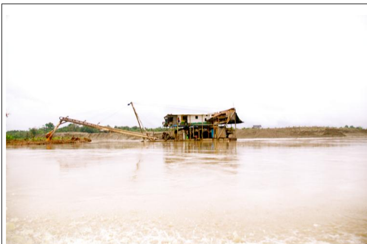
Folio 2114 del Cuaderno de pruebas Núm. 5. Draga o "dragón" -como los denominan las comunidades locales- realizando actividades de remoción de arena en el lecho del río Quito (afluente del Atrato). Enero 29 de 2016.
