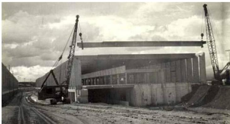
Figura 15 - Colocação das vigas
