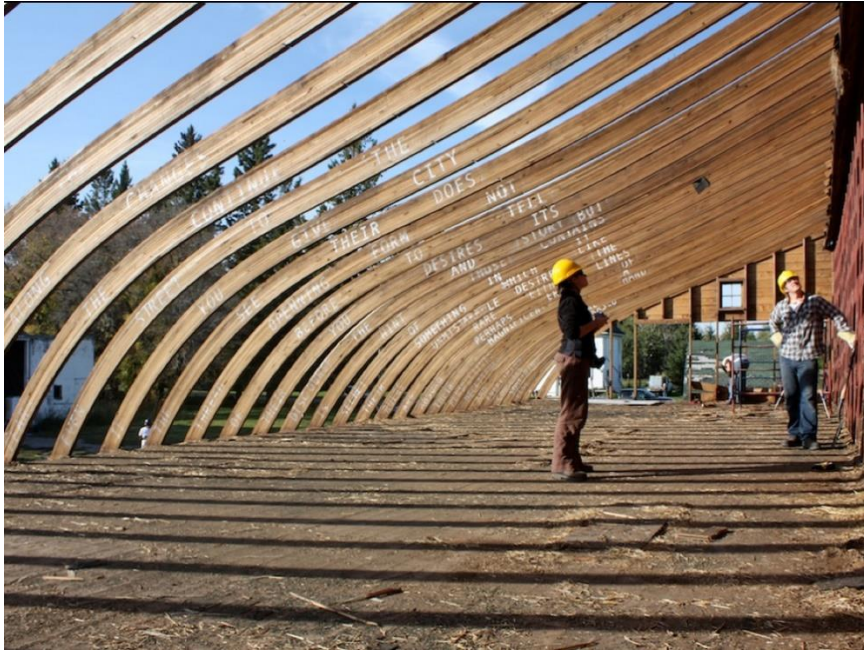
Figura 26 - Extensão do Depósito – Durante a Intervenção. Fonte: (COAR, 2017).
