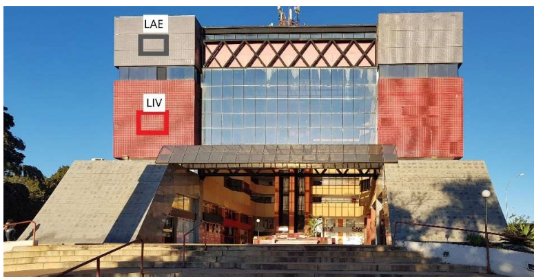
Figura 27 – Pontos de Medição na Fachada Nordeste
