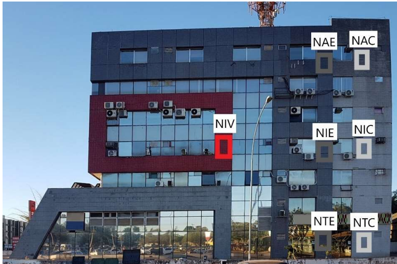
Figura 24 – Pontos de Medição na Fachada Noroeste
