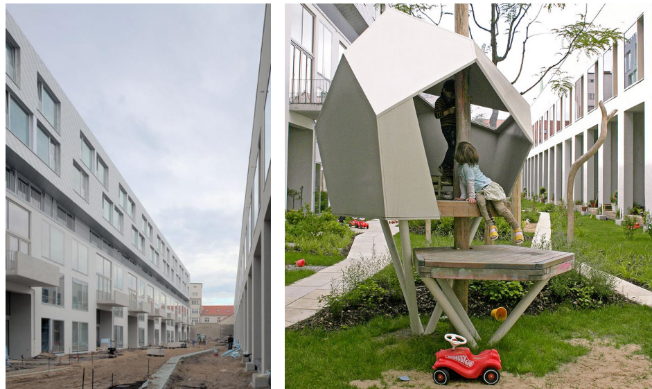
Figuras 70 e 71: Vista lateral direita do jardim interno em construção e vista do playground. Fontes: ARCH, Mies, 2013. Disponível em: < https://miesarch.com/work/1586 > Acesso em: 30/12/2018. ZENTRUM, Im Drausser, 2018. Disponível em: < https://www.draussen-im-zentrum.de/erweitert/bigyard/ > Acesso: 26/12/2018.
