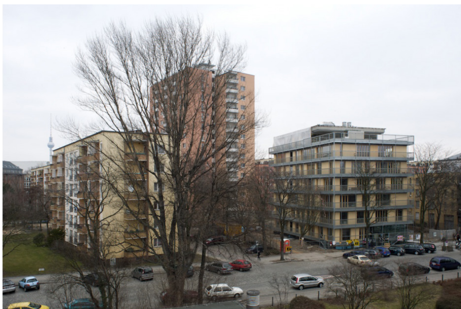
Figura 96: Vista aérea do projeto Ritterstrasse 50.
