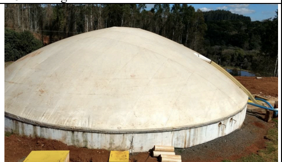
L - Biodigester Alemão ou CSRT (Continuous Stirred Tank Reactor – Tanque Reator de Agitação Contínua)
