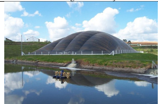
H - Biodigester Canadense ou Lagoa Coberta
