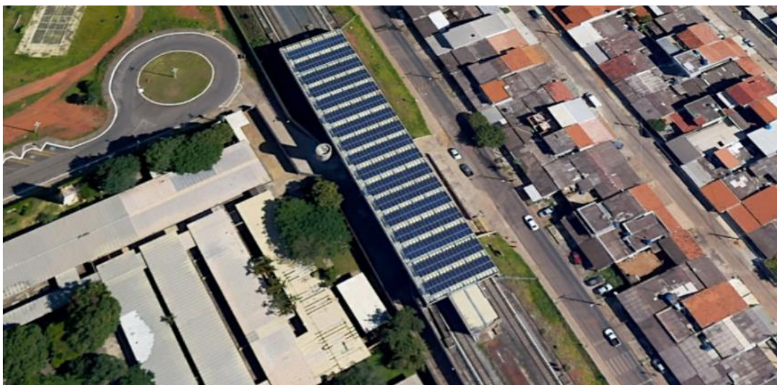
Figura 3.15 - Metrô-DF, Estação Guariroba, Ceilândia. Fonte: Google Earth Pro.
