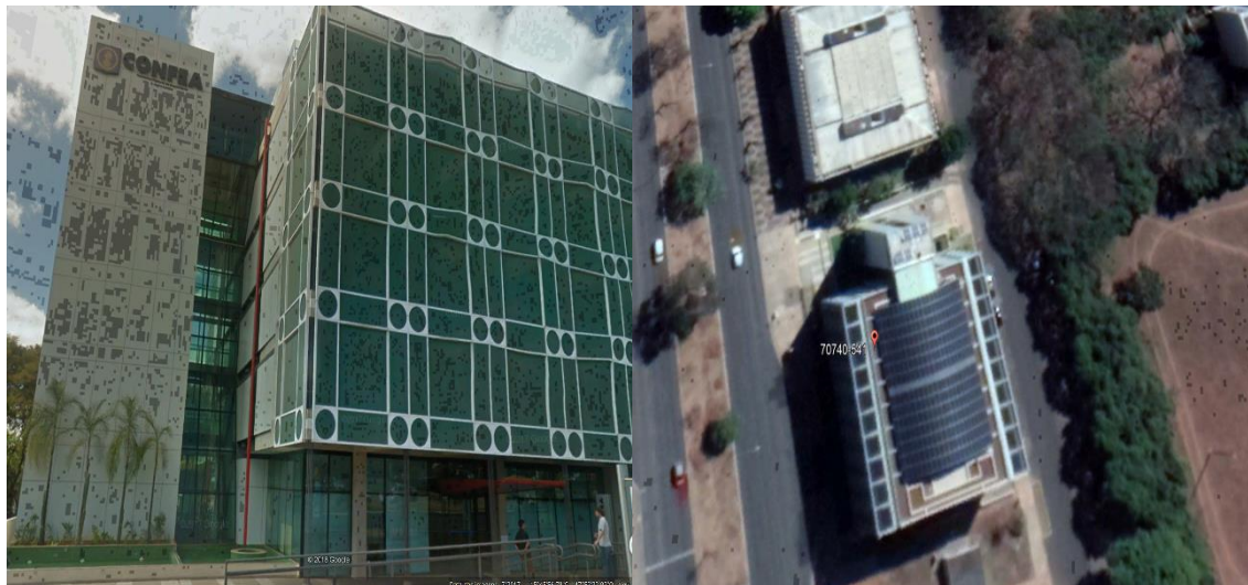
Figura 3.4 – Geração de energia solar no CONFEA/Brasília-DF. Fonte: Google Earth Pro/2018
