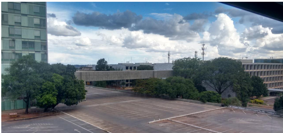
Figura 4.15 - Ministério, túnel e anexo
