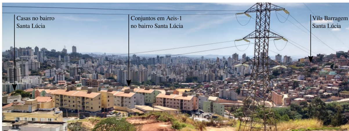
Figura 3.10: Foto dos conjuntos construídos na Aeis-1 do bairro Santa Lúcia
