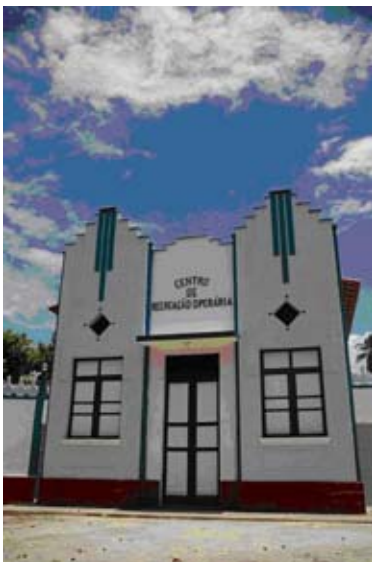
Fachada atual, após reforma realizada novembro de 2005. Foto: Suzete Bomfim, 2006.
