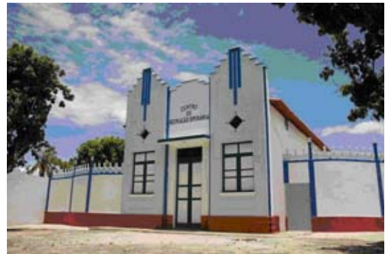
Fachada atual, após reforma realizada novembro de 2005. Foto: Suzete Bomfim, 2006.
