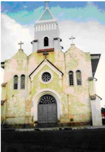
Igreja Santa Cruz, passando por reformas em 2004. Foto: Suzete Bomfim,2004.
