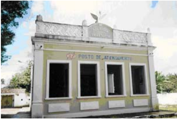
Fachada da Biblioteca união têxtil, usada hoje como posto de atendimento da Sulgipe. Foto: Suzete Bomifm, 2002.
