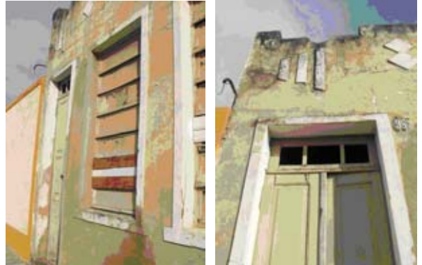
Detalhes da fachada, 2006.
