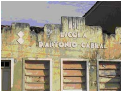
Detalhe da fachada, em 2006. Foto: Suzete Bomfim.
