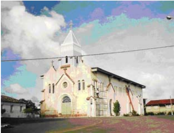
Igreja Santa Cruz, passando por reformas em 2004. Foto: Suzete Bomfim,2004.
