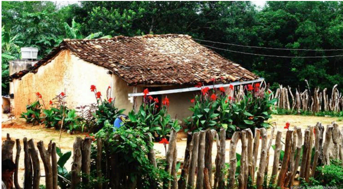
Figura 90: Foto de um dos modos de construir Xakriabá, com telhas de barro produzida no próprio território. Foto: Edgar Correa Kanaykô (2009).
