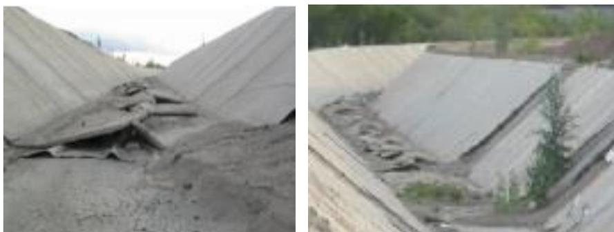
Figura 1.1. Problemas de execução em canal de transposição de água (Bresciani, 2011).
