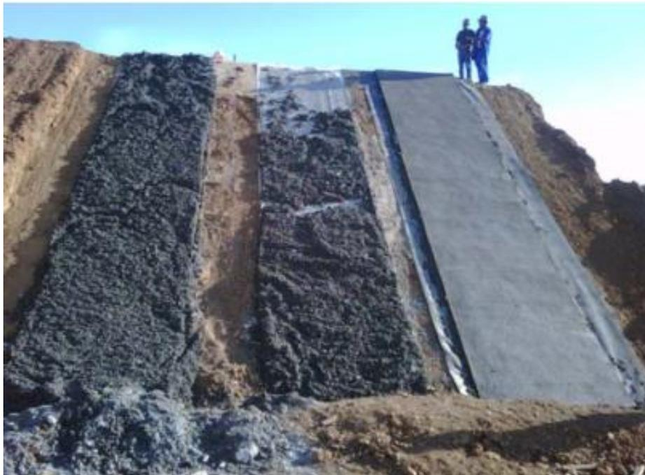
Figura 2.14. Aspecto geral das geomembranas após a colocação do concreto (da esquerda para a direita: baixa aspereza, lisa e de alta aspereza) (Abramento *et al.*, 2010).
