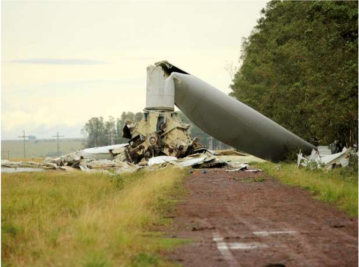
Figura 1-1 Acidente registrado em Santana do Livramento (G1 RS, 2014)
