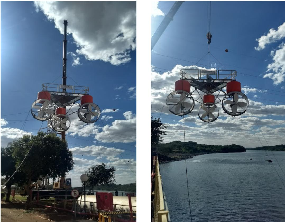
Figura 61 – a) Preparação e b) Içamento do arranjo modular de turbinas hidrocínéticas na água. Fonte: Mac Donald et al. (2018).
