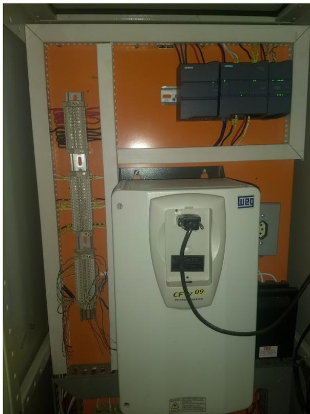
Figura 34 – Instrumentação do acionamento - Inversor de frequência e CLP.
