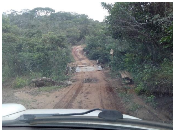
Estrada que liga o povoado de Macacos ao alojamento do PNSV localizado no Campo São Domingos. O acesso em veículos demanda que esses sejam com tração 4x4.
