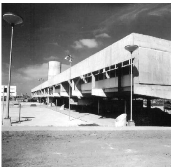
Fig. 24 (esq.) GE Nova Utinga, 1972. Não há separação entre o edifício e a comunidade. O térreo em pilotis o integra ao espaço urbano.
