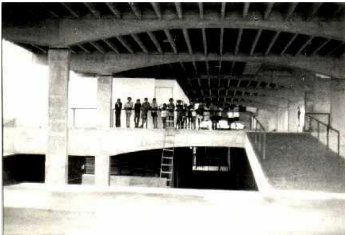
Fig. 56 Dario Montesano, arquiteto. Grupo Escolar Nova Utinga, 1972. Rampas de acesso entre o piso inferior e o térreo. Acervo pessoal de Dario Montesano.
