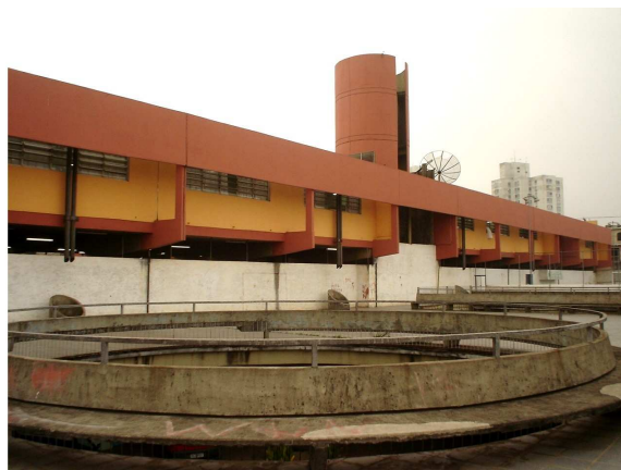
Fig. 71 (dir.) O pátio aberto. Vê-se ao fundo o muro que criou uma divisão entre os pátios, 2006. Foto do autor.
