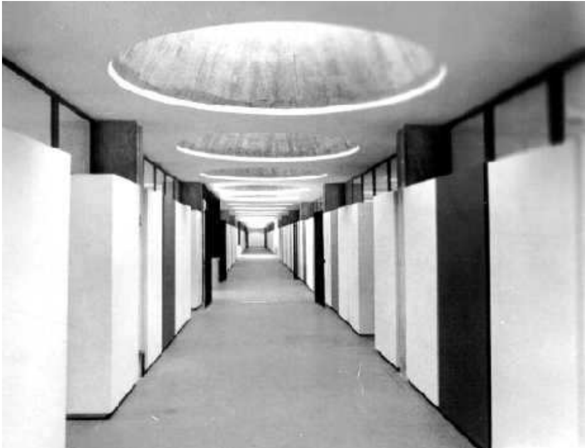
Fig. 28 GE Nova Utinga, 1972. Corredor do piso superior. As divisões são feitas pelos armários e por caixilhos acima deles. Acervo pessoal de Dario Montesano.
