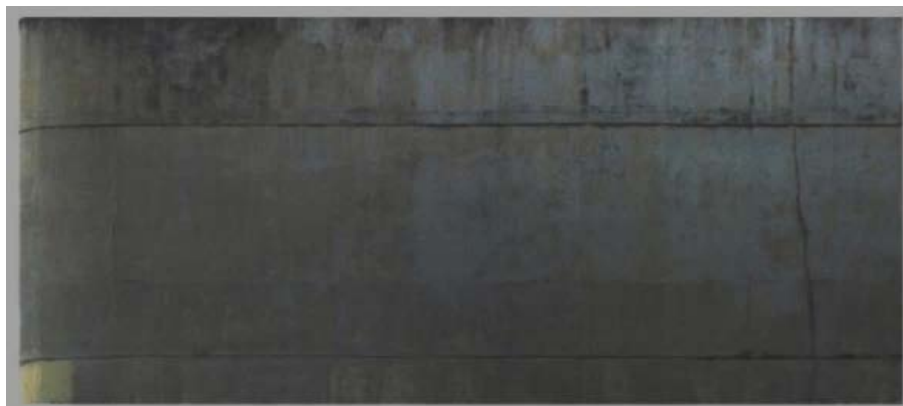
Figura 11 - Modelo 1: ortomagem gerada de uma das fachadas da Biblioteca Central
