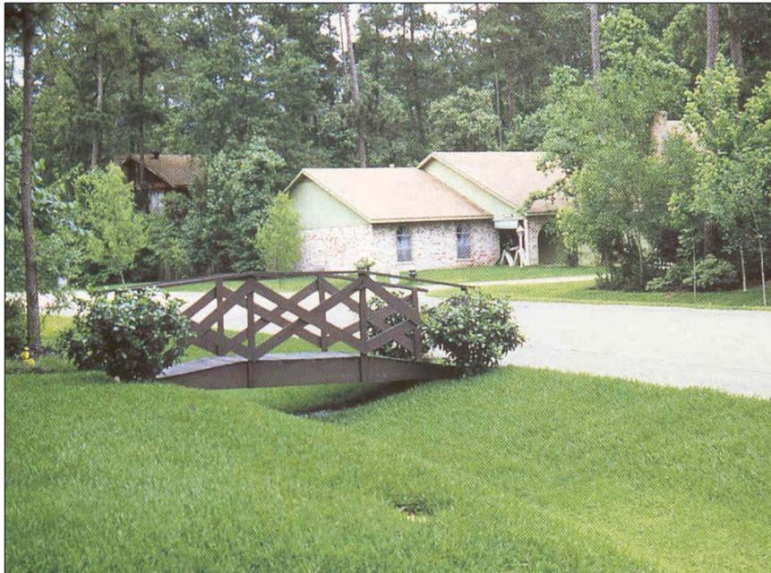
Figura 3.13 – Exemplo de vala de infiltração (Certu, 1998)
