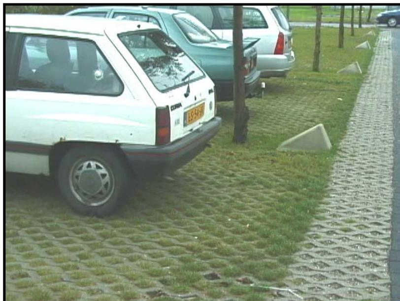
Figura 3.5 – Exemplo de pavimento permeável
