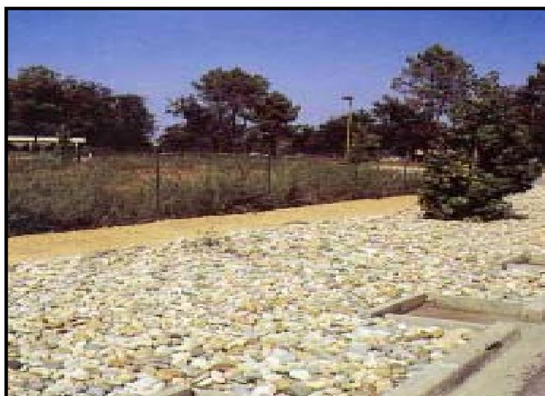
Figura 3.11 – Exemplo de trincheira de infiltração (CETE DU SUD-OUEST, 2003)
