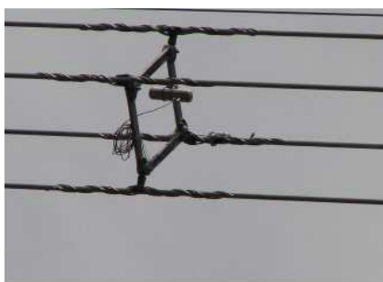
(d) Pavica 06P21 e Vibrec 500 instalados
