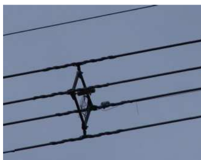
(d) Pavica 06P21 e Vibrec 500 instalados
