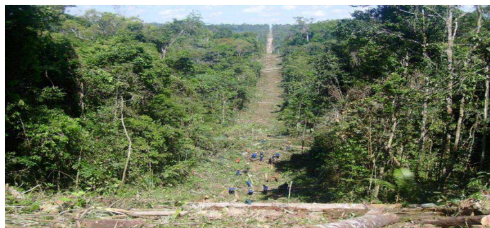
Figura 1.5 - Abertura da faixa de servidão (Eletronorte, 2010).
