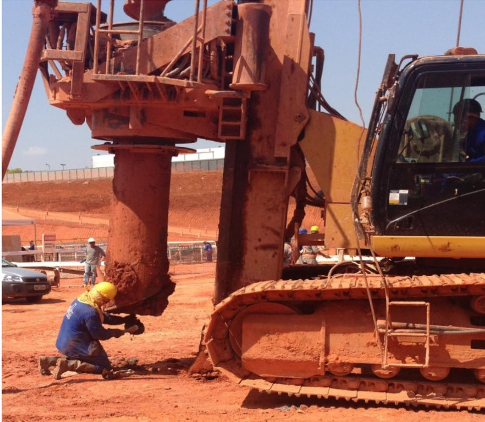
**Figura 2.2** – Colocação da tampa provisória no trado da hélice
