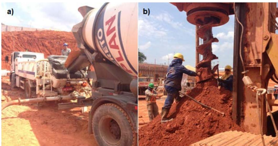
**Figura 2.4** – a) Lançamento do concreto no caminhão guia; b) Concretagem com simultânea limpeza do trado
