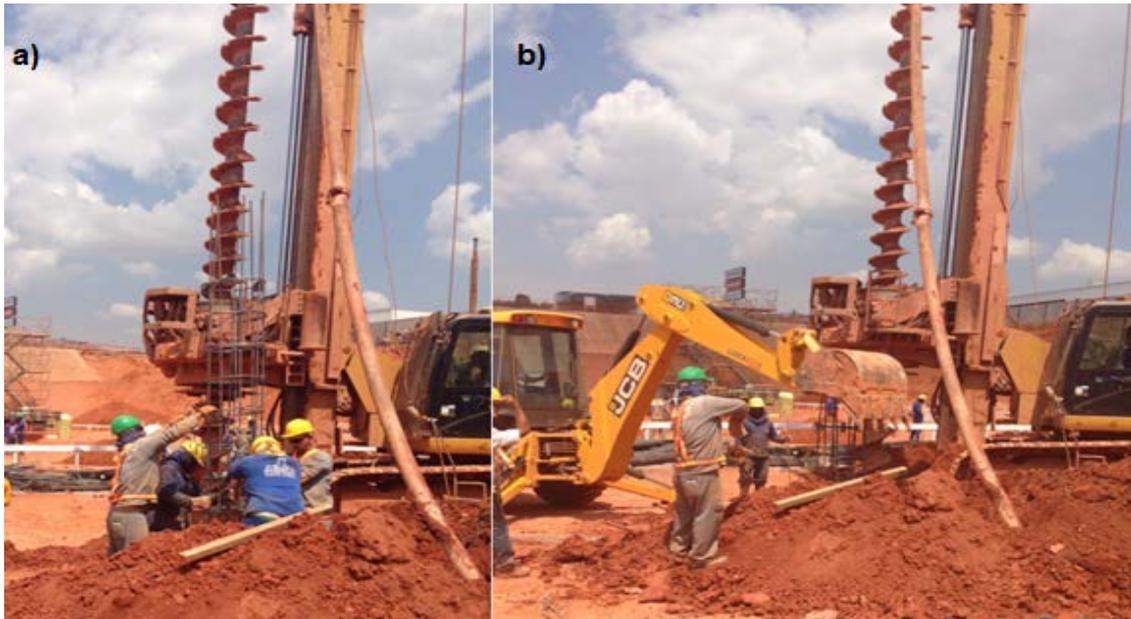
**Figura 2.5** – a) Colocação da armadura manualmente; b) Com o auxílio da pá-carregadeira
