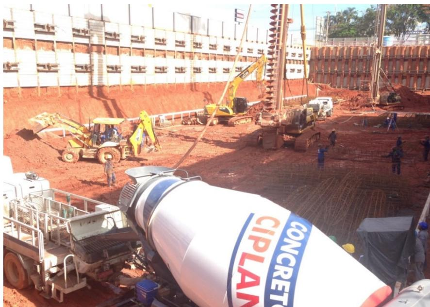
**Figura 2.6** – Equipamentos utilizados durante a execução de uma estaca hélice contínua
