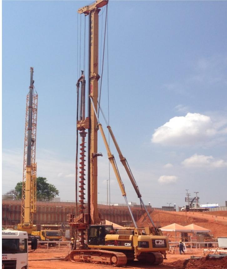
**Figura 2.3** – Perfuração no terreno a partir da hélice
