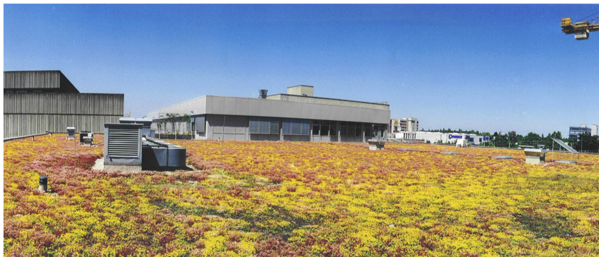
Figura 4.5 Cobertura verde do tipo extensivo (vegetação tipo Sedum ). Behnisch, Behnisch & Partner, Instituto Alterra, Wageningen, Países Baixos (1993-98). Fonte: GAUZIN-MÜLLER, 2002.
