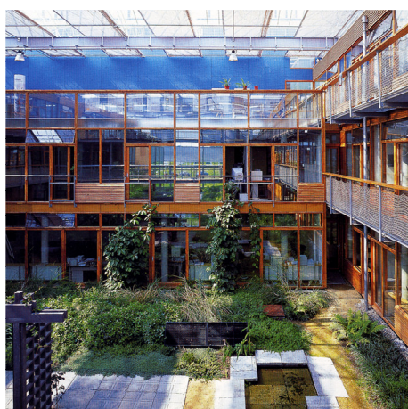
Figura 5.18 Behnisch, Behnisch & Partner. Instituto Alterra, Wageningen, Países Baixos (1993-1998). Vista externa parcial. Fonte: GAUZIN-MÜLLER, 2002.
