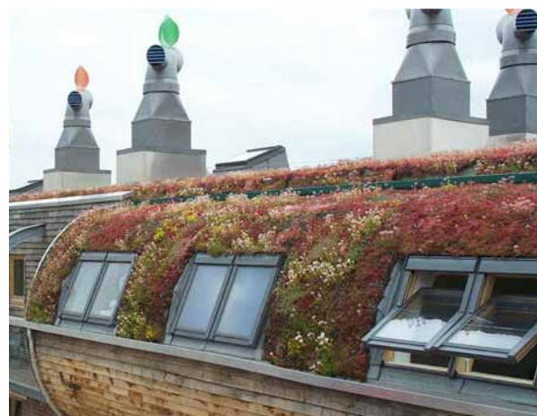
Figura 4.6 Cobertura verde do tipo extensivo (vegetação tipo Sedum ). Bill Dunster Architects, Conjunto BedZed, Londres, Reino Unido, 1999-2001.
