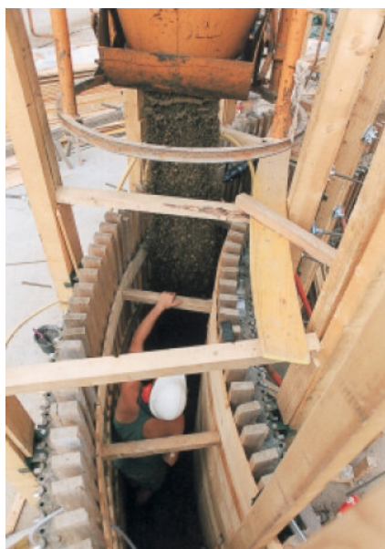
Figuras 5.23 a 5.25 Processo mecanizado de execução de taipa: lançamento, compactação e retirada das fôrmas, respectivamente (Capela da Reconciliação, Berlim). Execução: Lehm Ton Erde (Áustria). Fonte: WIECKHORST, 2003.
