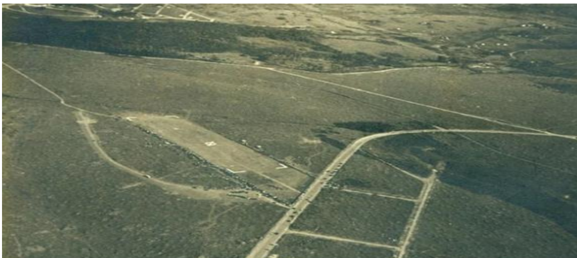
FIGURA 15. Área da construção do Aeroporto de Congonhas, década de 1930
