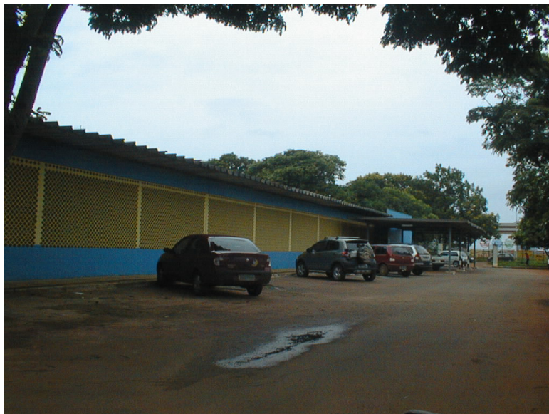
Figura 7 – Fachada lateral esquerda
