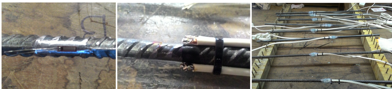
Figura 3.8: Instrumentação das barras.
