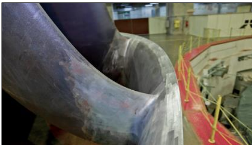
Figura 4 - Turbina reparada da unidade geradora 6 (U6) da UHE Itaipu.
