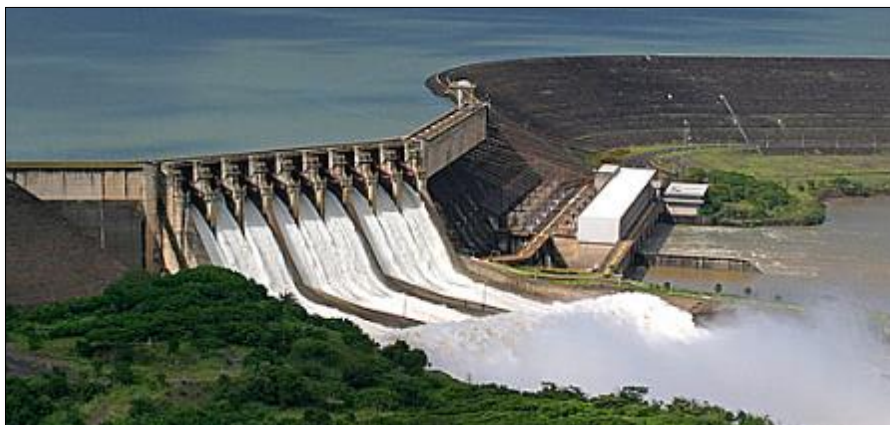
Figura 1 - Usina hidrelétrica de São Simão, Goiás.
