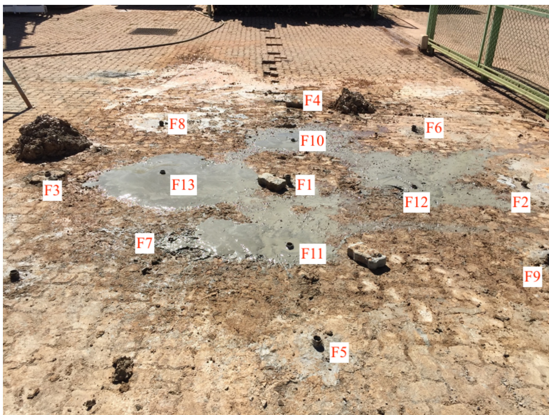
Figura 5.17 – Vista superior após a finalização da execução das injeções
