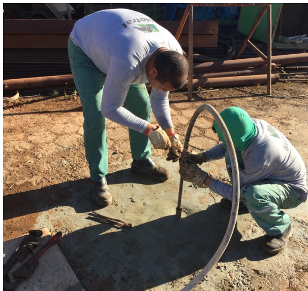
Figura 5.5 – Injeção das válvulas manchete, após a cura da bainha por 12h.
