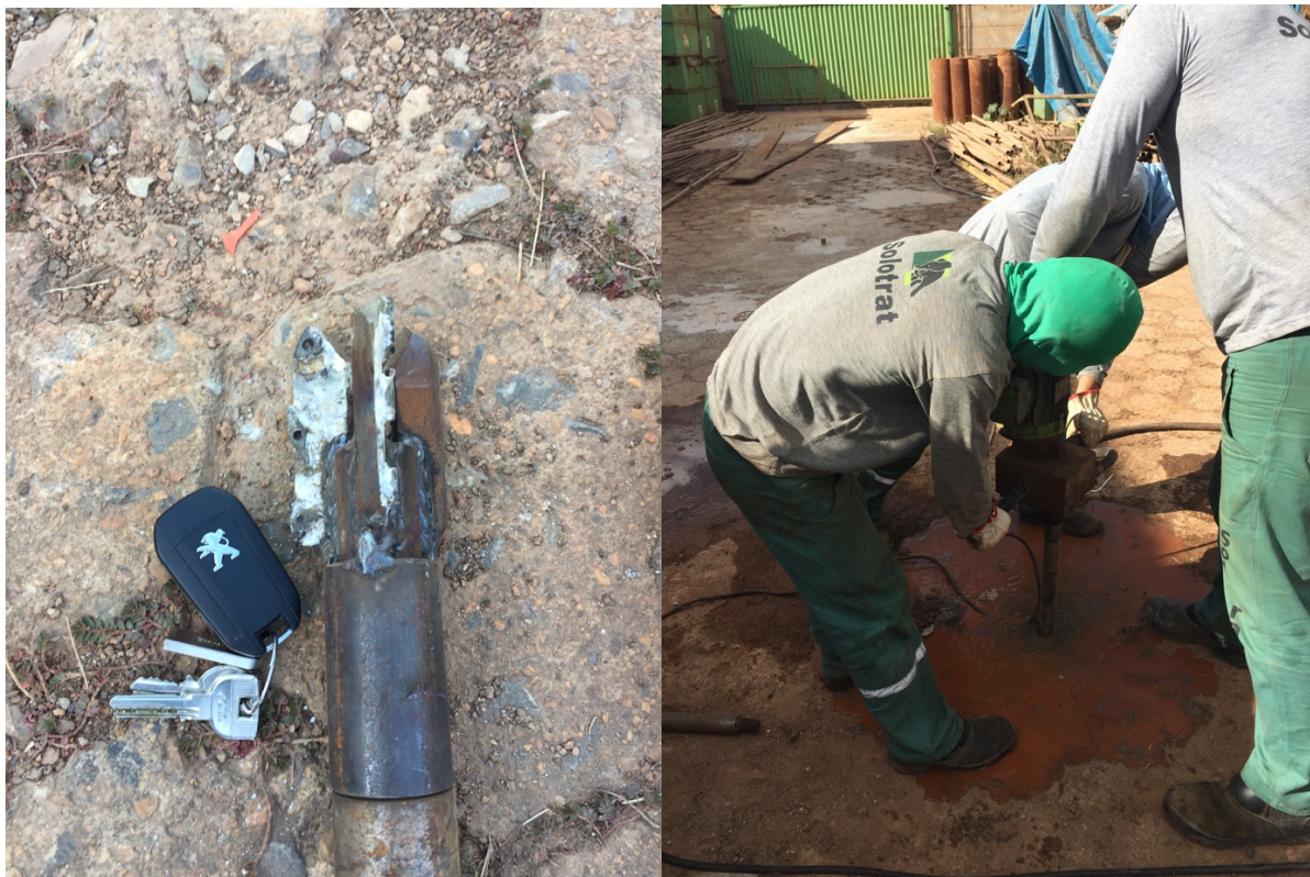
Figura 5.3 – Detalhe do bit de perfuração (tricone com inserts de carboneto de tungstênio) e da perfuração dos furos, feita utilizando água como fluido de perfuração
