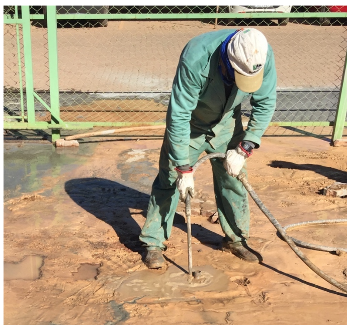
Figura 5.10 – Injeção da bainha, de baixo para cima
