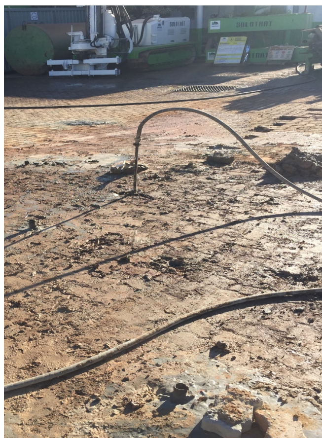
Figura 5.12 – Injeção das manchetes mais profundas, mangueira e obturador inseridos no tubo PVC mancheteado
