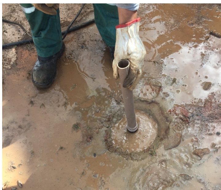
Figura 5.4 – Inserção do PVC manchettato até a cota de fundo (3,5 m)
