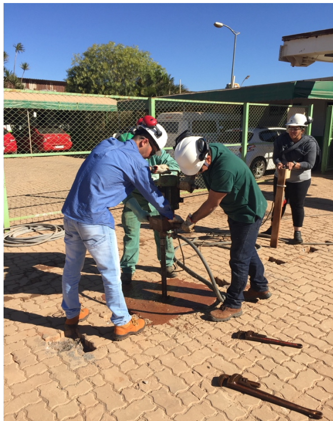
Figura 5.9 – Perfuração dos furos por meio de perfuratriz elétrica, com circulação de água, com o mesmo tricône da Fig. 5.6
