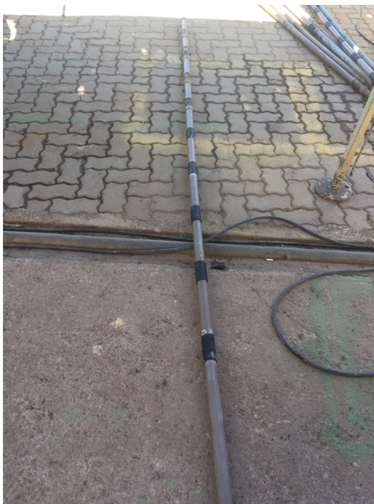
Figura 5.8 – Tubo PVC manchetado (330 mm de espaçamento entre manchetes, em preto).
