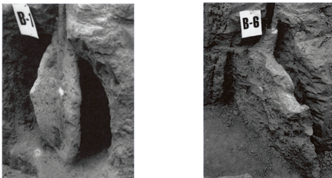
Figura 3.18 – Escavação de colunas de injeções de compactação (B1) e injeções de fraturamento com fluido viscoso (B6) (modificado – Warner, 2004)
