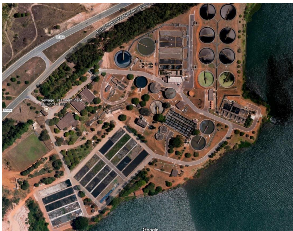
Figura 1 – ETE Norte. Fonte: Google Maps.
