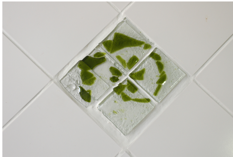
Figura 10 – Azulejos de garrafas de vidro fundidas e cerâmicas industriais aplicados em revestimento de cozinha (Módulo II). Fonte: Adriana Villela, arquivo da pesquisadora, 2004.
