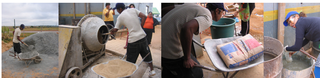
Figura 67 – Mistura da massa de concreto para os blocos, Washington e Anastácia, 2006
