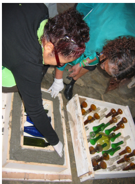
Figura 43 – Arrumação das garrafas nas formas para concretagem
