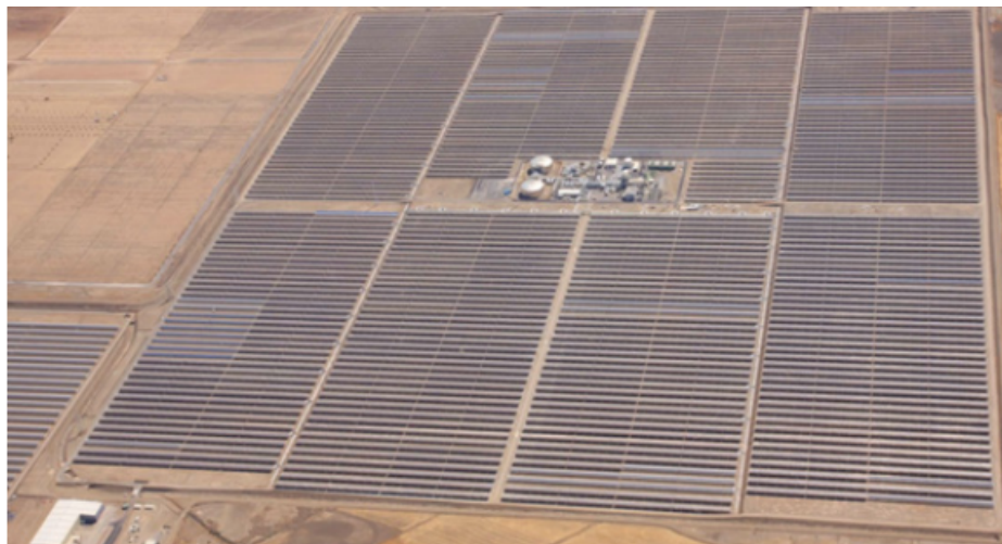
Figura 4 – Campo de coletores solares com o bloco de geração de potência e tanque de reservatório térmico - 50 MW Planta Andasol Localizada na Espanha).
