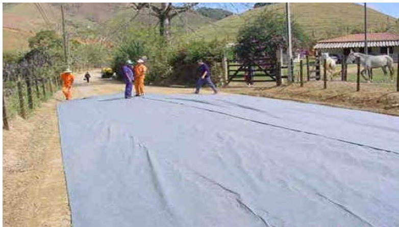
Figura 2.15 – Aplicação de geotêxteis não-tecidos em obras de pavimentação (Fonte: Informativo Bidim, 2006).
