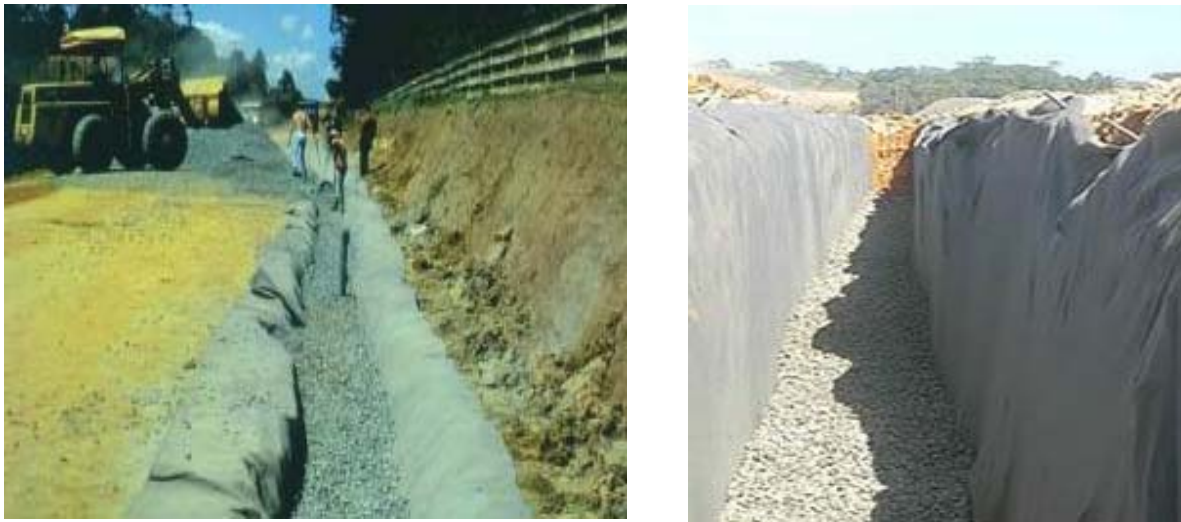
Figura 2.1 - Sistemas drenantes convencionais.
