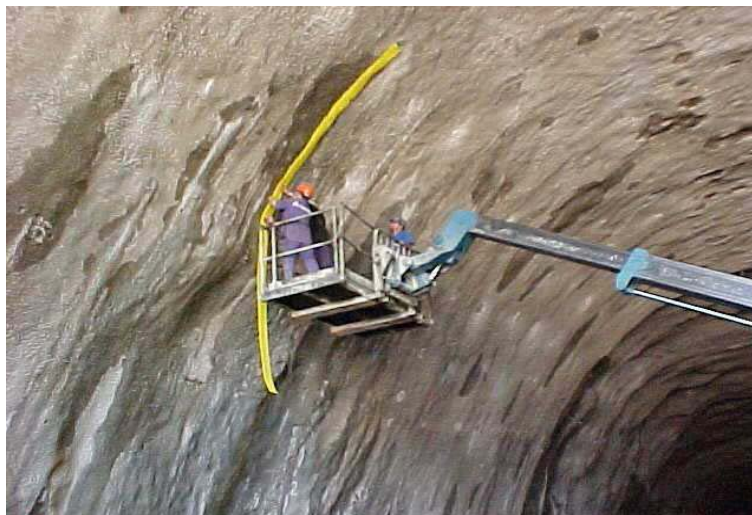
Figura 2.10 – Aplicação de geossintético no revestimento de um túnel (Fonte: Informativo Bidim, 2006).
