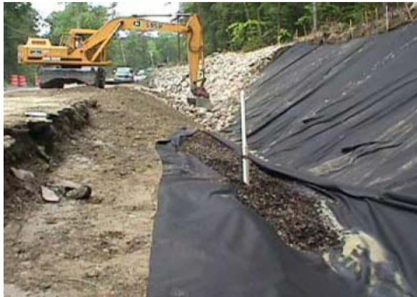
Figura 2.7 – Aplicação de pneus picotados na drenagem lateral de uma rodovia (Fonte: Construction Report, 2001).
