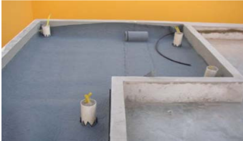
Figura 2.11 – Geocomposto aplicado na drenagem de jardim em contato com laje de concreto (Fonte: Maccaferri – Case History, 2005).
