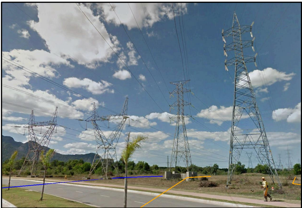
Figura 4.18. Vista da faixa compartilhada entre as LTs de 345 kV e 138 kV (fonte: Google Street View).
