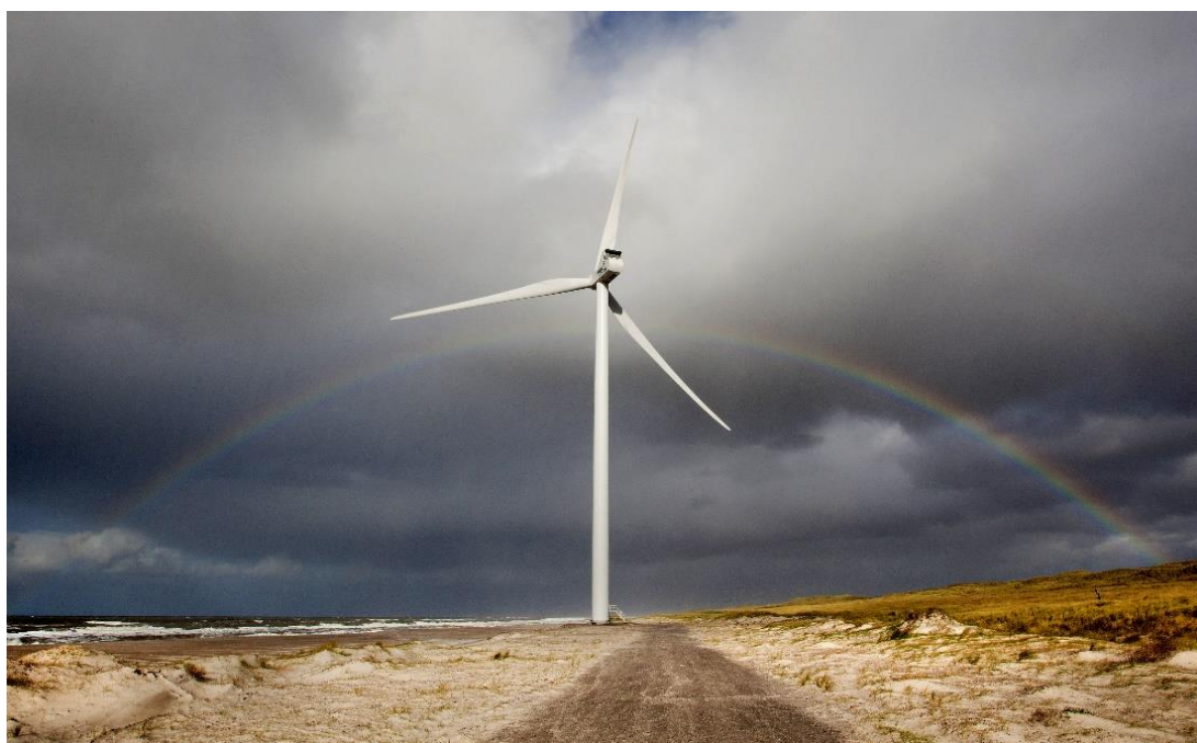
Figura 2.1 – Turbina eólica de eixo horizontal modelo V112-3. (Fonte: Vestas, 2017).
