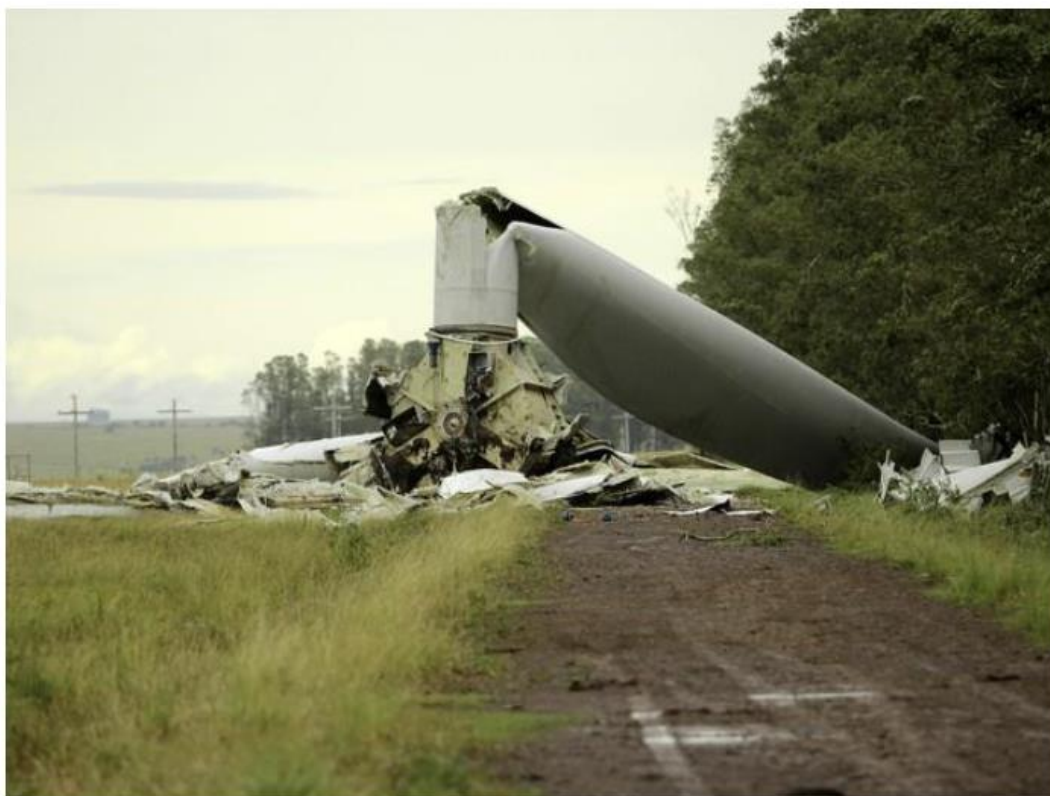
Figura 1.4 – Torre eólica caída no Complexo do Chato. (Fonte: Ribeiro, 2014).
