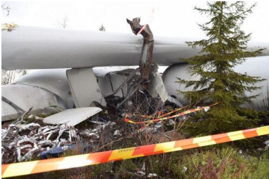
Figura 1.2 – Torre eólica em colapso integral no parque eólico Lemnhult, Suécia. (Fonte: portal-energia.com).
