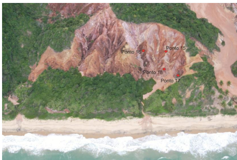
Figura 5.32 - Praia e erosão de Coqueirinho
