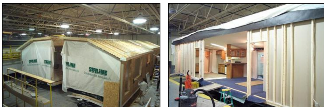
Figura 65 – Montagem de mobile homes em indústrias dos EUA. Fonte: SKYLINEHOMES (2007).
