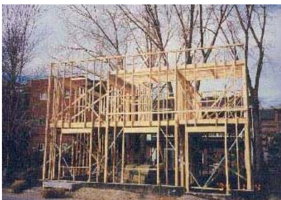
Figura 63 – Obra no Canadá e detalhe do sistema balloon . Fonte: HOMETIPS (2007).
