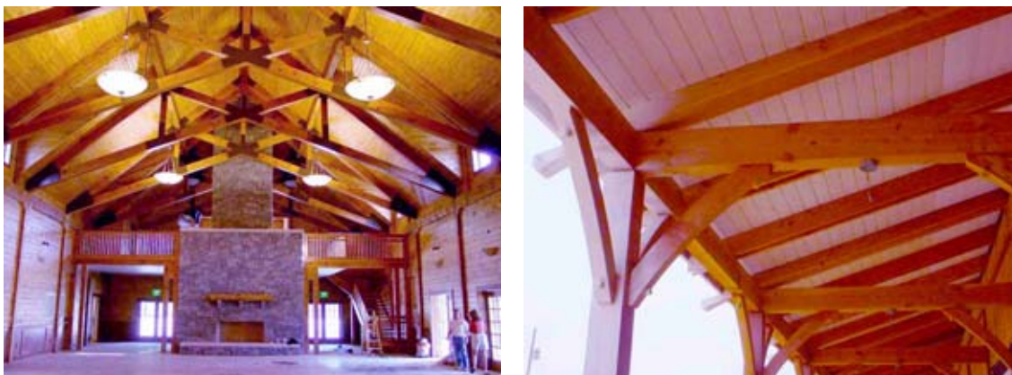
Figura 61 – Habitações com sistema pilar-viga nos EUA. Fonte: PIONEERLOGSYSTEM (2006).
