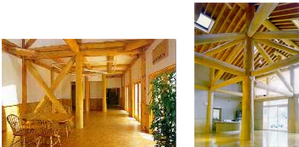
Figura 62 – Sistema pilar-viga com madeira roliça no Canadá. Fonte: CANADIANLOGHOUSE (2006).
