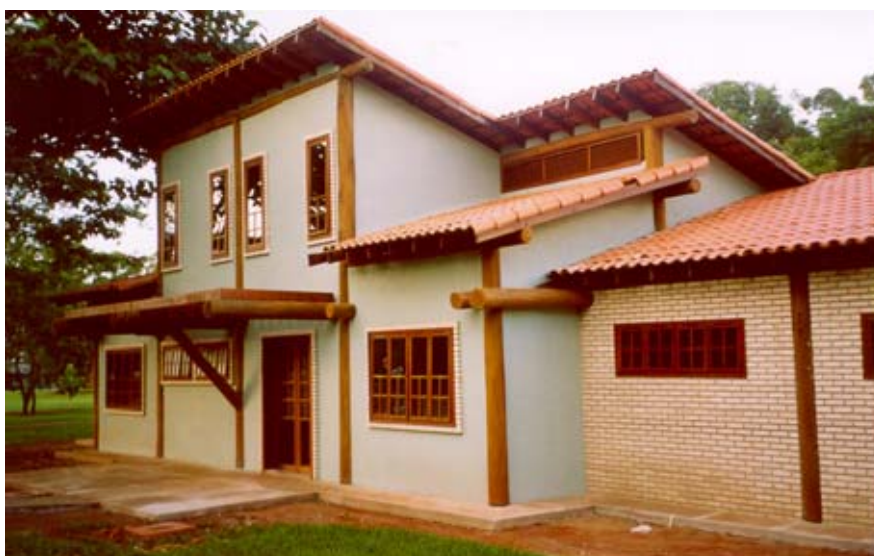
Figura 60 – Edificação com sistema pilar-viga e vedações em alvenaria, destinada ao centro de plantas medicinais do IBAMA/DF. Fonte: MELLO (2004).
