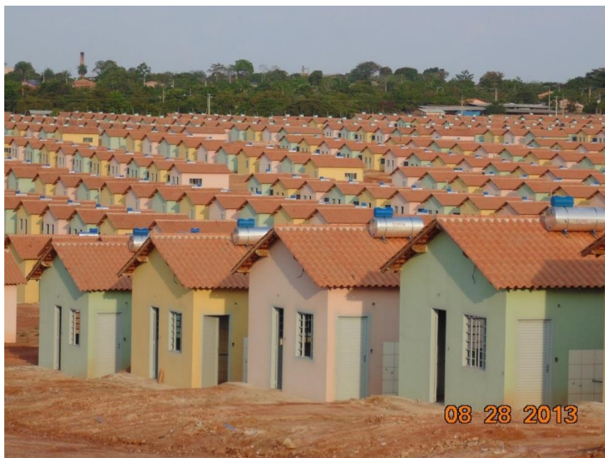
Figura 43 Casas do residencial Salvação são equipadas com aquecimento de água do chuveiro
