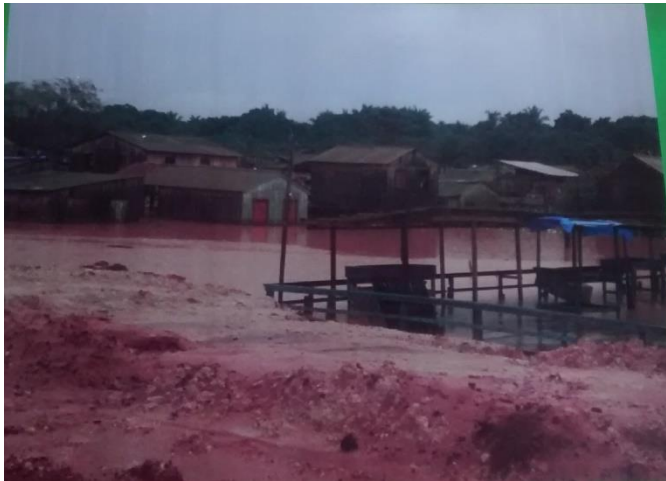
Figura 32 Início da execução das obras do PAC I no bairro Uruará
