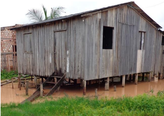
Figura 19 Casa de palafita remanescente na área de intervenção do PAC I
