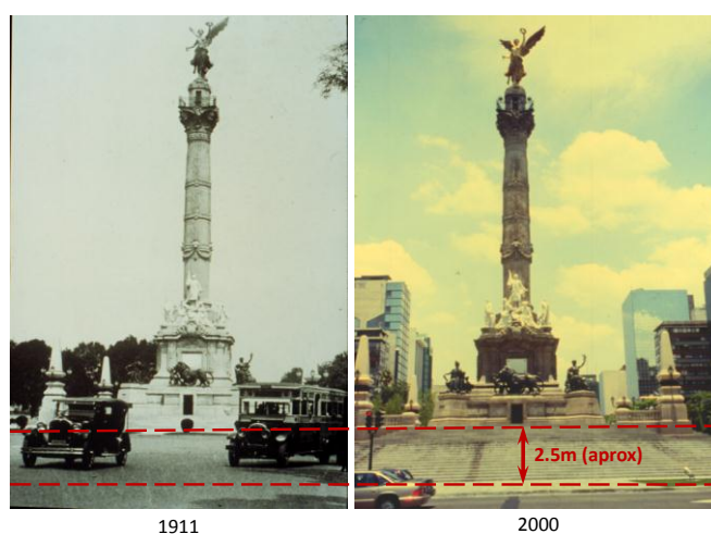
Figura 2.17. Subsidência no Monumento do Anjo da Independência ( Rodríguez, 2010)
