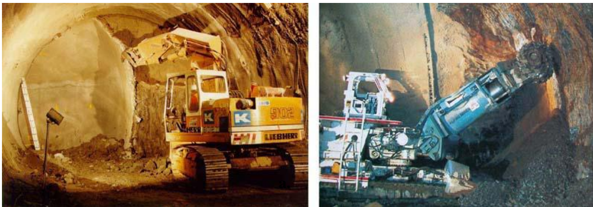
Figura 2.6 a) Escavadeira em Túnel de Teste em Heathrow - London. b) Escavação com Fresa na Estação Subterrânea Exchange Place - Jersey City, (Sauer & Mergelsberg, 2003)
