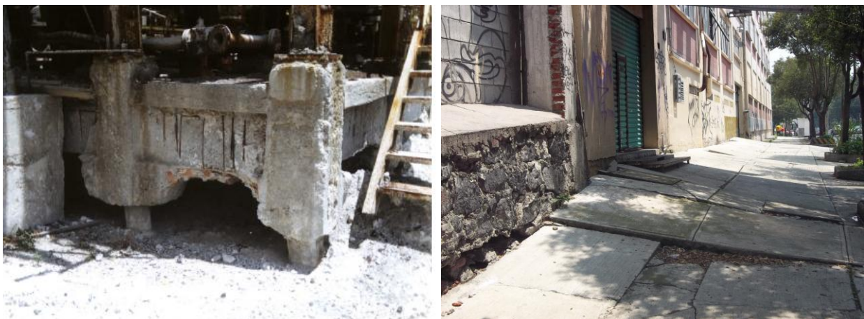
Figura 2.14. Emerção aparente das estacas e outras estruturas (Zaldivar, 2013)
