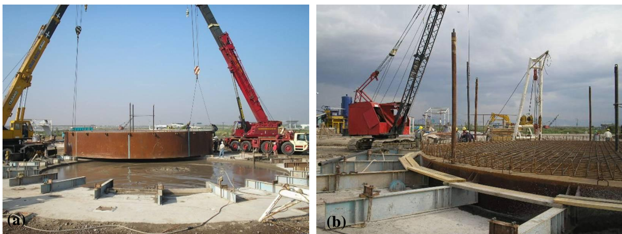
Figura 3.20. (a) Imersão do tanque de flutuação e (b) construção da laje de fundo (Auvinet & Rodríguez, 2010)
