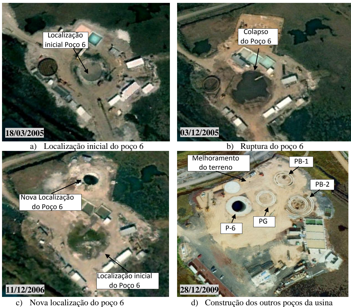
Figura 3.17. Processo construtivo da usina de bombeamento “Casa Colorada” (Google Earth, 2005, 2006, 2009)
