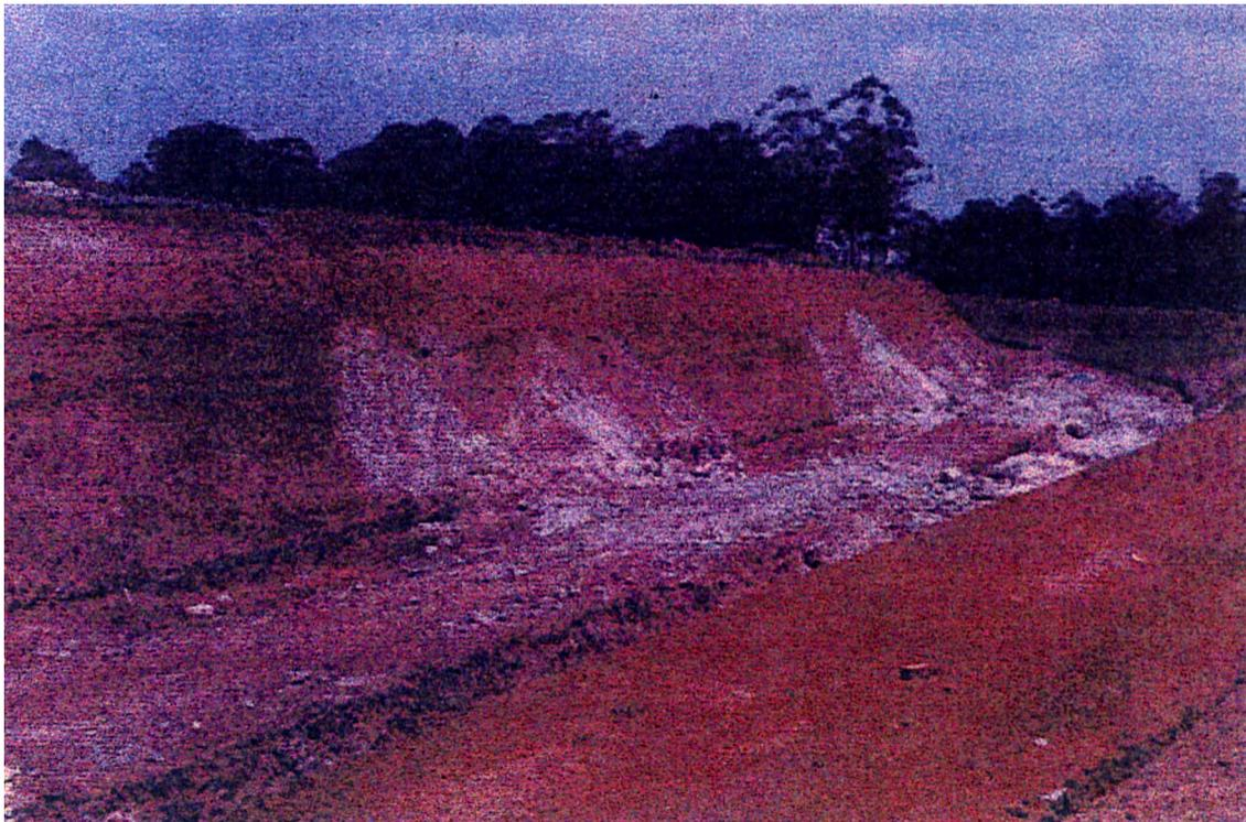
**Figura 5.5** - Foto da vista geral dos solos residuais da toposseqüência de Águas Claras (Talude sul do metrô). As porções esbranquiçadas representam o solo saprolítico.
