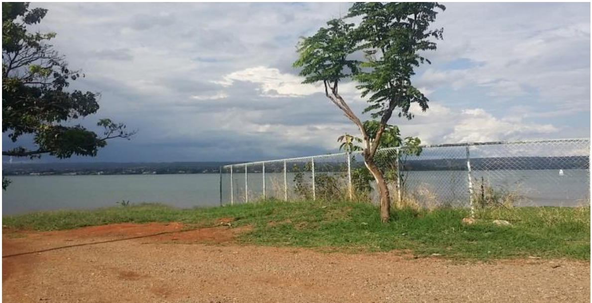
Figura 81: Sobra de terreno no SHTN, Trecho 2
