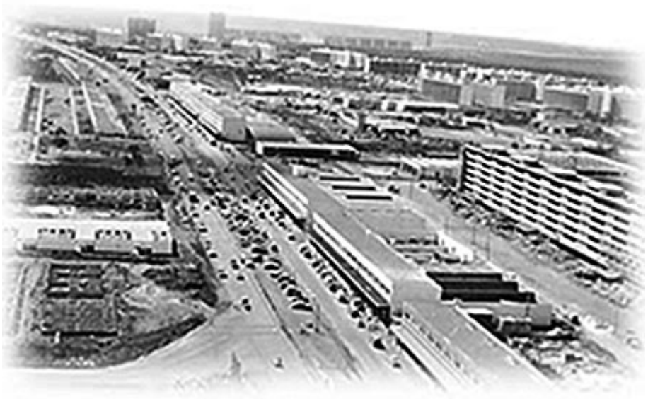
Figura 5 – Construção de Brasília, dos anos 1970 (Arquivo Público do Distrito Federal)
