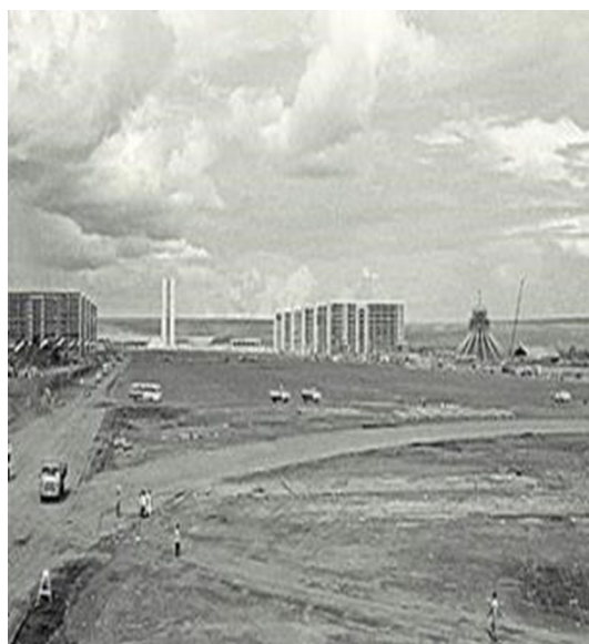
Figura 4 – Construção de Brasília, dos anos 1960 (Arquivo Público do Distrito Federal)
