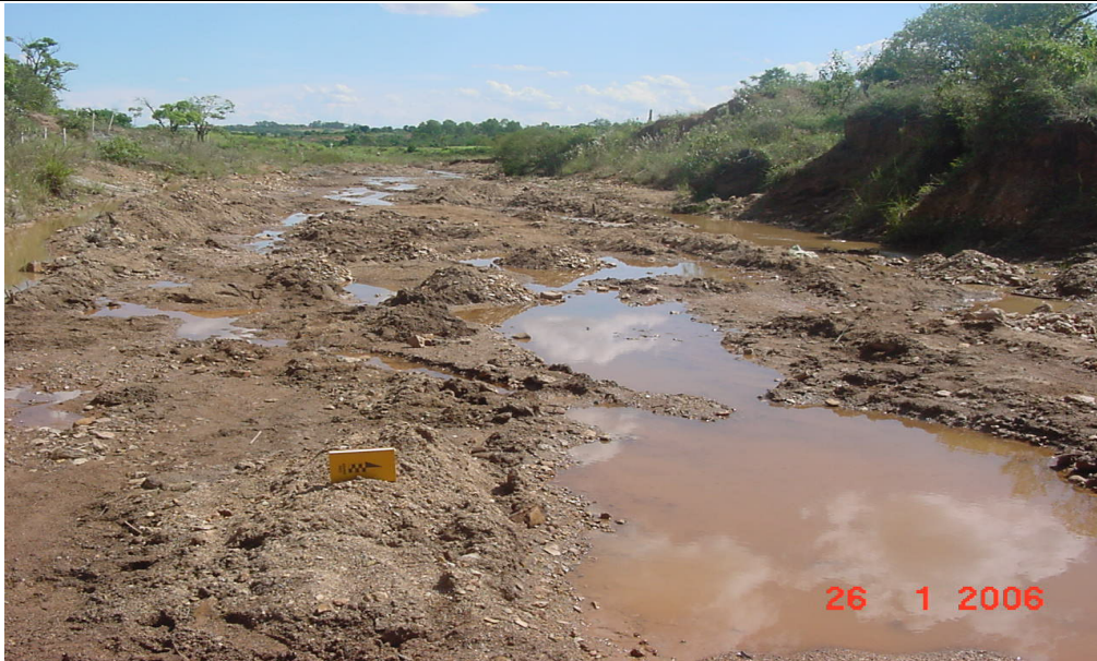
Figura 1.1. Estado de degradação atual da calha do Córrego Rico próximo à nascente.
