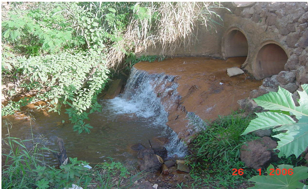
Figura 1.2. Esgoto lançado sem tratamento no Córrego Rico.
