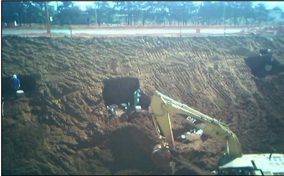
Figura 4.1 - Retirada das amostras de blocos indeformados para os ensaios.
