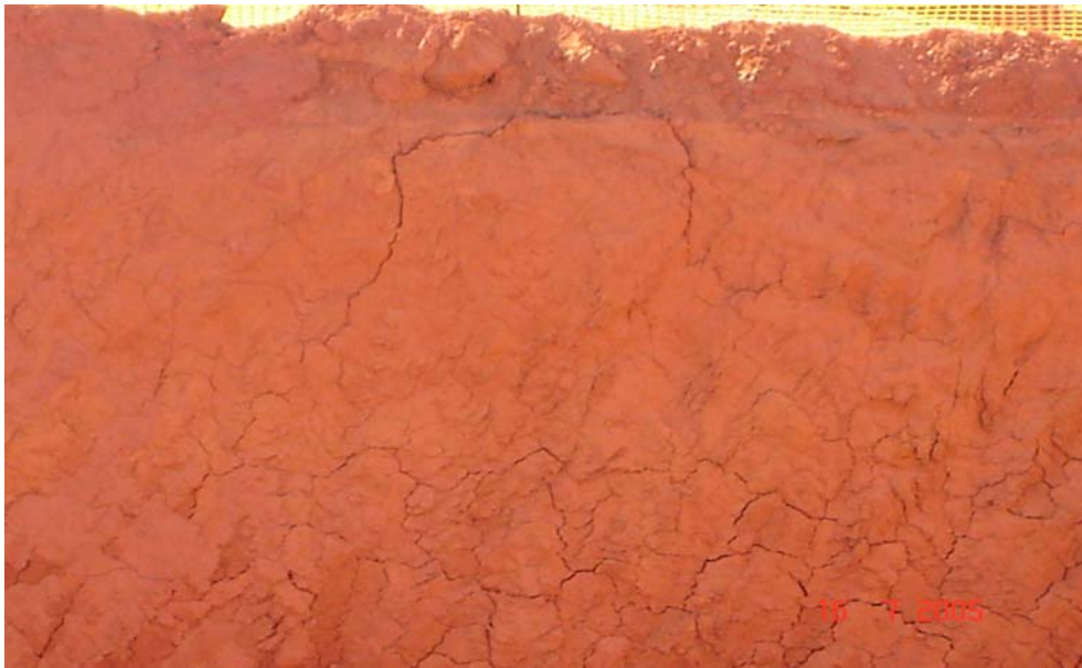
Figura 5.8 - Visualização das trincas de retração no perfil do talude em estudo.
