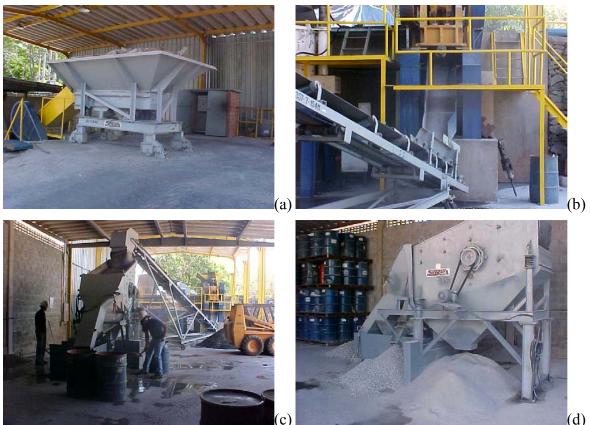
Figura 3.3 - Britador de mandíbulas - processamento dos resíduos sólidos: (a) caçamba de alimentação; (b) britador e correia transportadora; (c) vista geral do sistema de britagem; (d) peneiramento e descarga do material.
