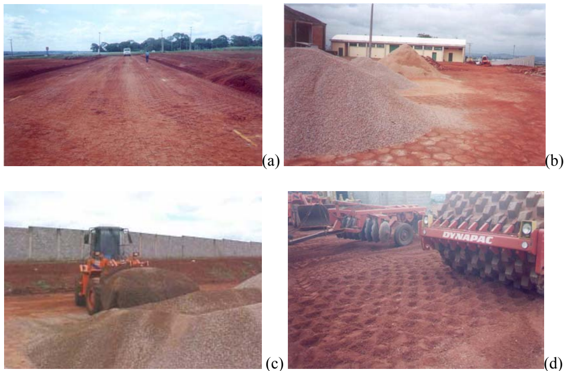
Figura 3.9 - Execução da pista experimental: (a) subleito compactado; (b) pilhas de agregados reciclados; (c) processo de homogeneização na pista; (d) compactação da sub-base.
