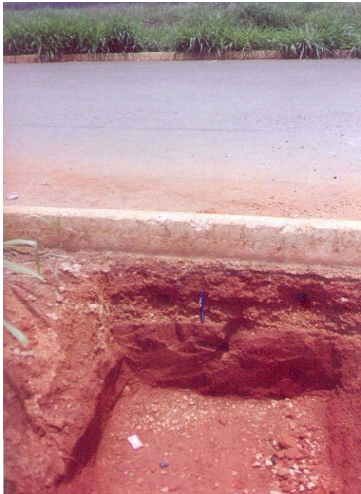
Figura 4.55 – Furos horizontais dos ensaios pressiométricos nas camadas de base, sub-base e subleito da pista experimental (CEASA) – estaca 4 BD – Novembro de 2005.
