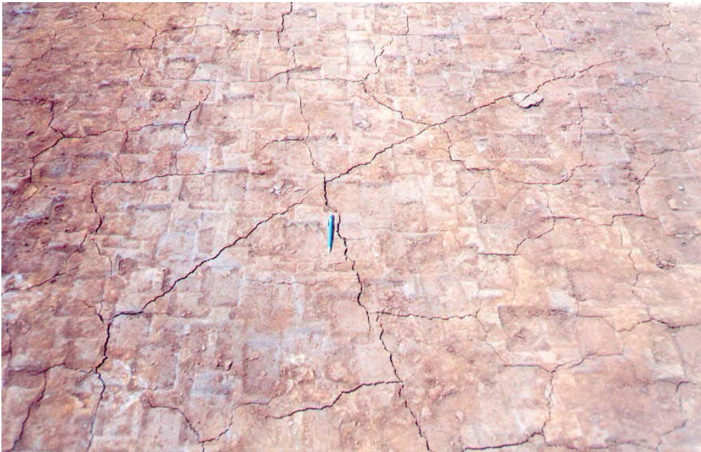
Figura 4.44 - Trincamento do subleito da pista experimental após a compactação – Novembro/2003.
