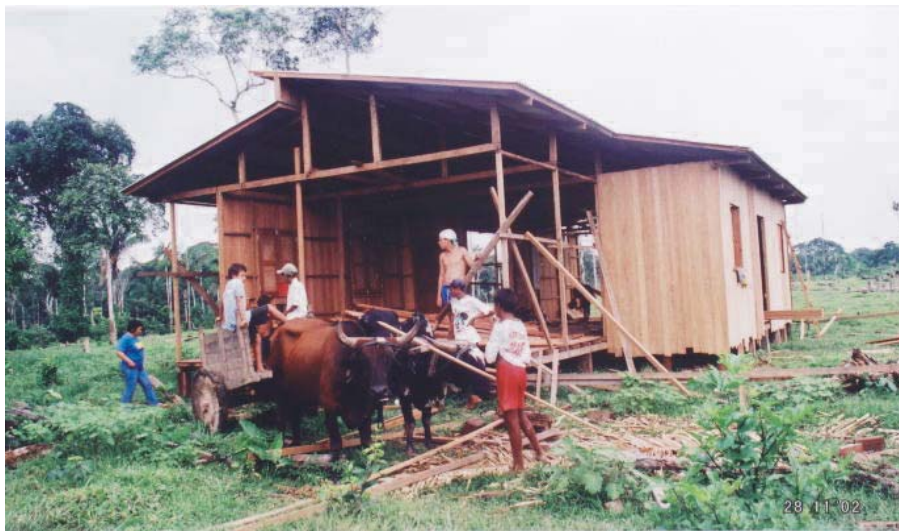
Foto 7: Construção de uma escola comunitária.
