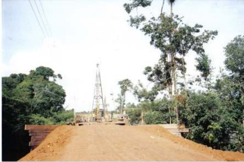
Estrada e ponte. Obras de recuperação.
