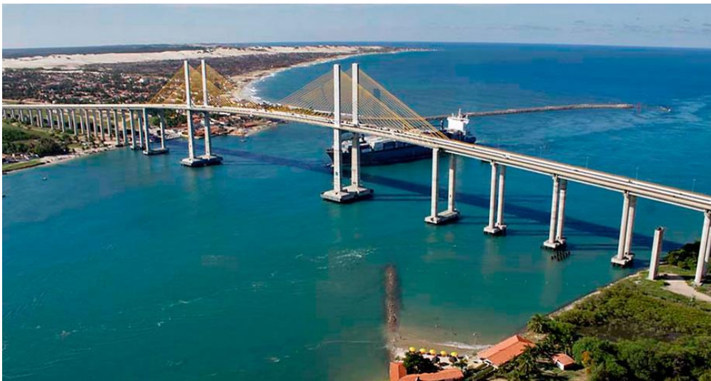
Figura 1.2: Ponte Newton Navarro, Natal / RN
