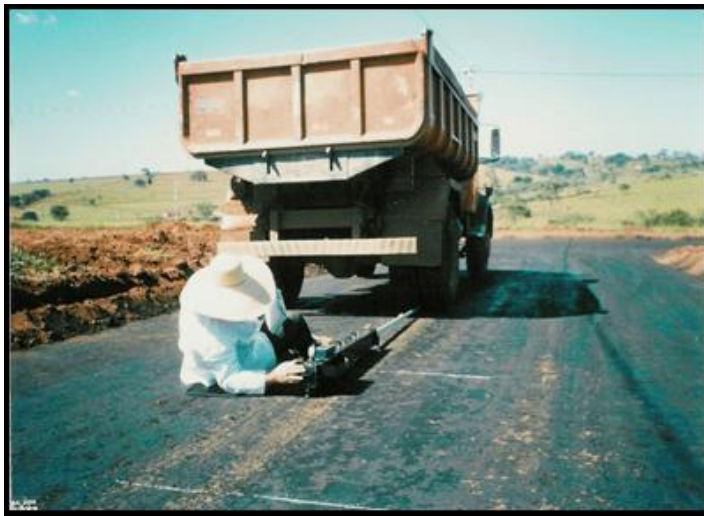
Figura 3.18 Ensaio de Viga Benkelman, realizado na pesquisa.
