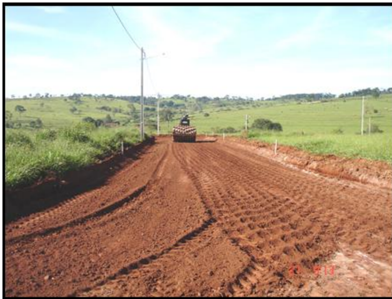
Figura 3.14. Compactação da camada de subleito com o uso do rejeito.
