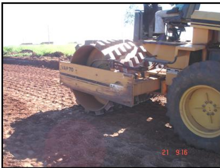
Figura 3.17. Compactação da Camada de Base, Compactador CA-25.
