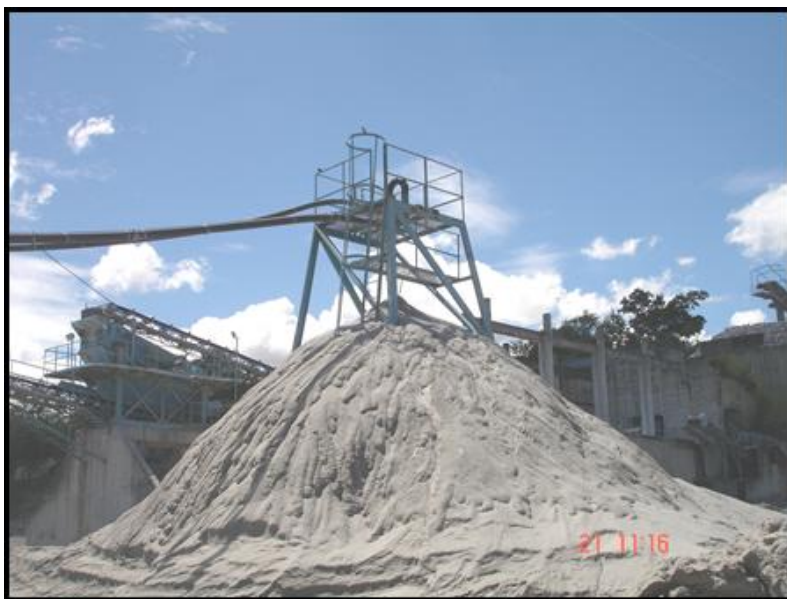
Figura 3.3. Hidro-ciclone e Pilha de Rejeito localizado na Pedreira Anhanguera.
