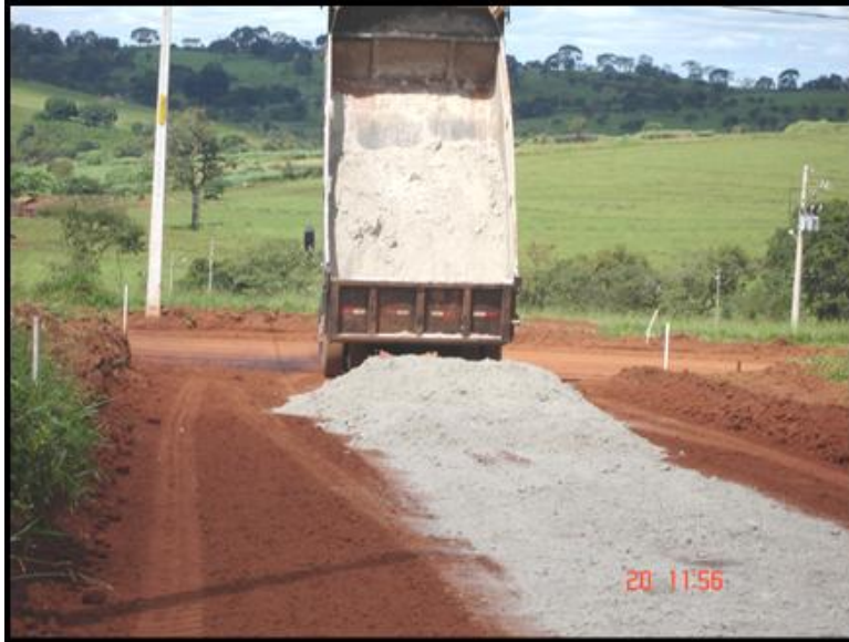
Figura 3.13. Pista experimental, adição de rejeito para reforço do subleito.
