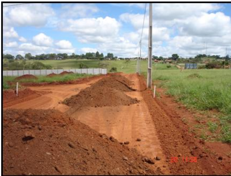
Figura 3.16. Lançamento do cascalho sobre a camada de subleito.
