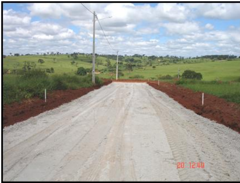
Figura 3.15. Secagem do rejeito na pista experimental em inhumas, Goiás
