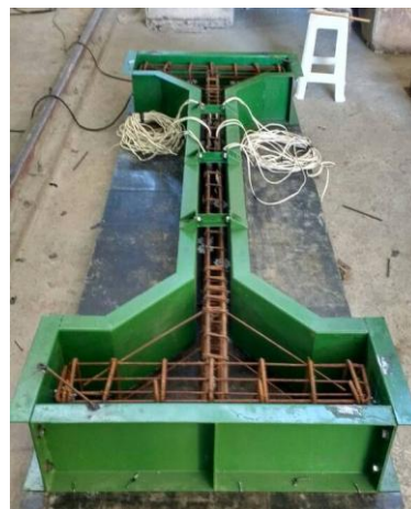
Figura 3.8 – Pilar pronto para a concretagem
