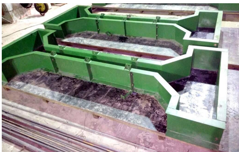
Figura 3.6 – Formas metálicas dos pilares
