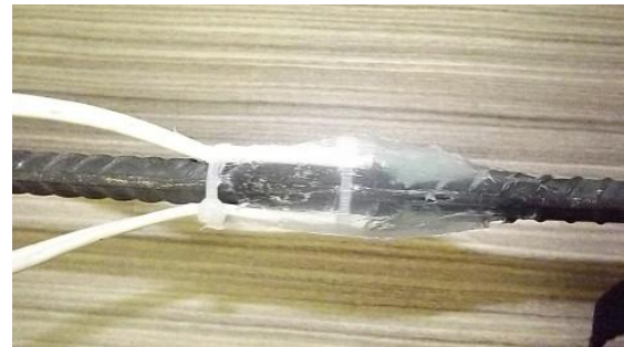
Figura 3.36 – Proteção com silicone
