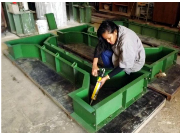
Figura 3.7 – Aplicação de silicone para vedação das frestas das formas e da base
