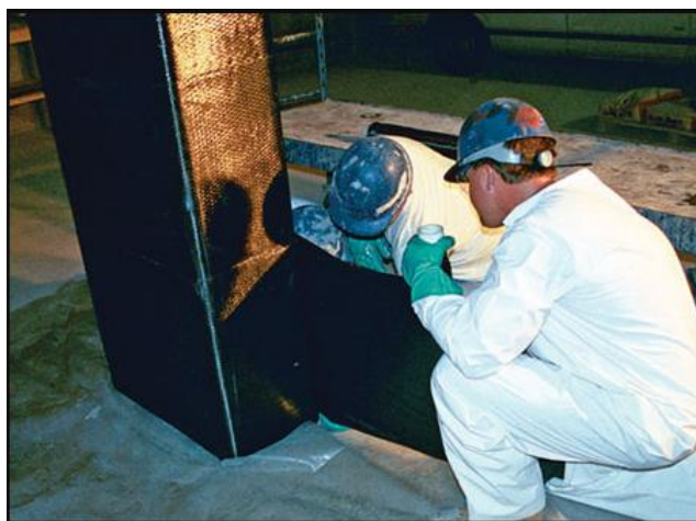
Figura 2.11– Reforço de pilares ao confinamento < http://www.structuremag.org/?p=8643 >
