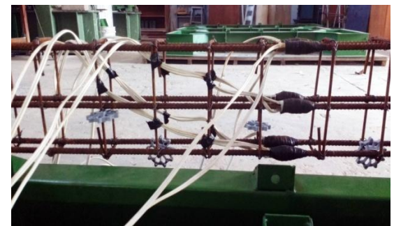
Figura 3.38 – Detalhamento final da instrumentação das armações dos pilares
