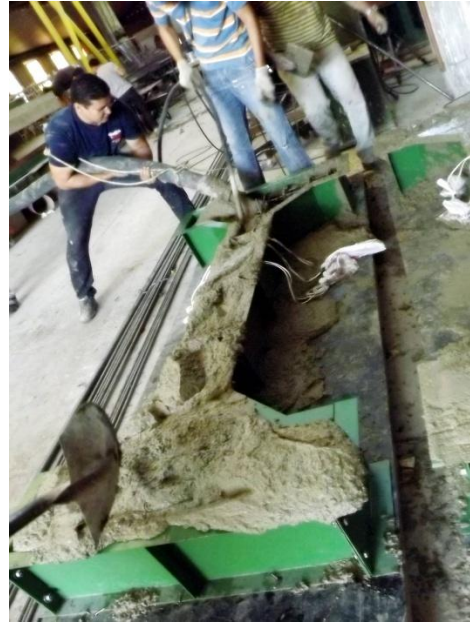
Figura 3.12 – Lançamento do concreto
