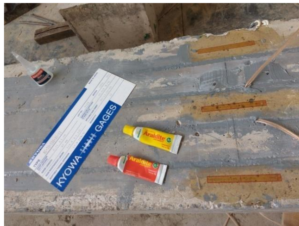
Figura 3.40 – Extensômetros colados na face do concreto
