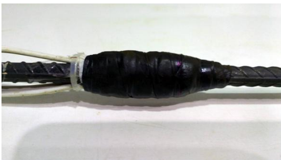
Figura 3.37 – Proteção com fita isolante de alta fusão
