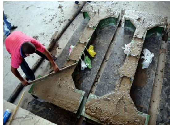
Figura 3.14 – Regularização da superfície
