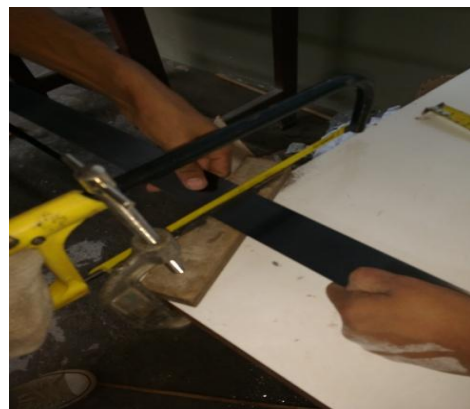
Figura 3.16 – Corte das lâminas com um arco de serra
