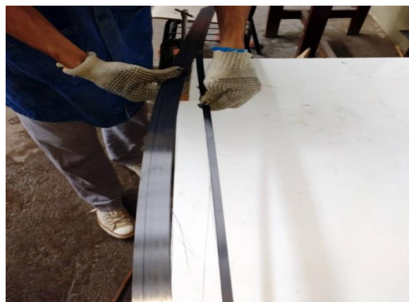
Figura 3.18 – Retirada das lâminas de CFRP
