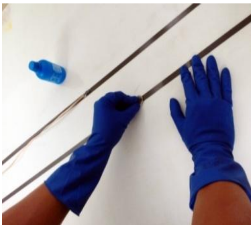
Figura 3.42 –Limpeza do reforço
