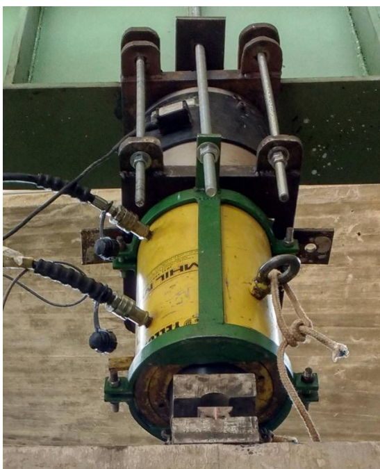
Figura 3.53 – Célula de carga alinhada com o macaco hidráulico
