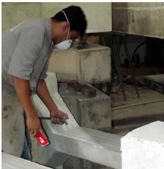
Figura 3.23 – Limpeza das aberturas com auxílio de uma espátula e ar comprimido.
