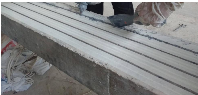
Figura 3.27 – Aplicação do reforço
