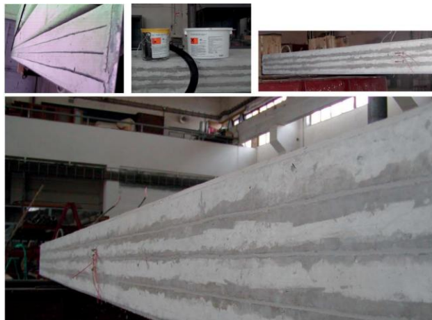
Figura 2.13 – Reforço a flexão de pilares pela técnica NSM (GAJDOSOVA, 2010).
