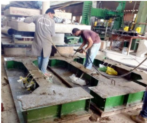
Figura 3.13 – Adensamento do concreto
