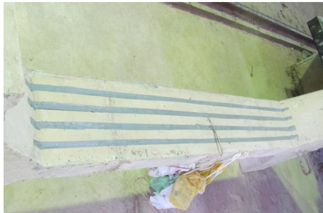
Figura 3.29 – Acabamento final do reforço
