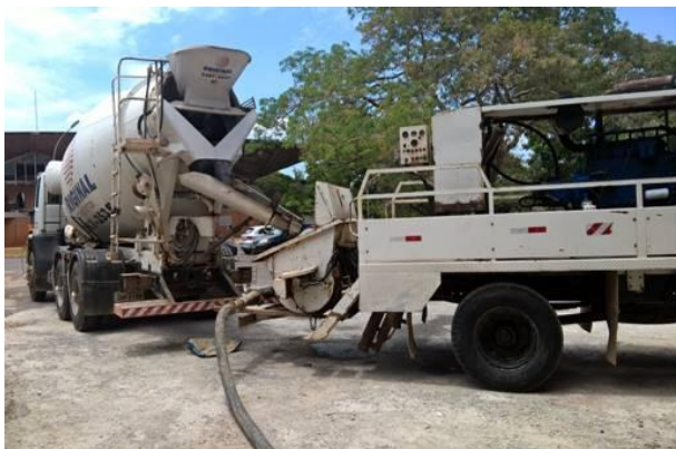
Figura 3.9 – Concreto sendo bombeado
