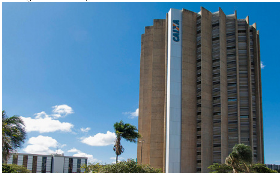
Figura A.23: 8ª parada – Sede da Caixa Econômica Federal
