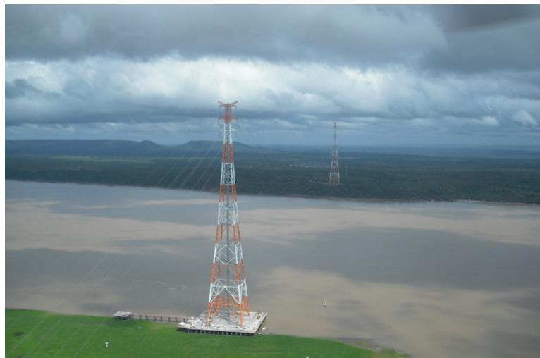
Figura 1.2 - Torres 238 e 241 da linha de transmissão Tucuruí-Macapá-Manaus com 300 m de altura e 2,5 Km de espaçamento entre elas (WIKIPEDIA.ORG, 2017).
