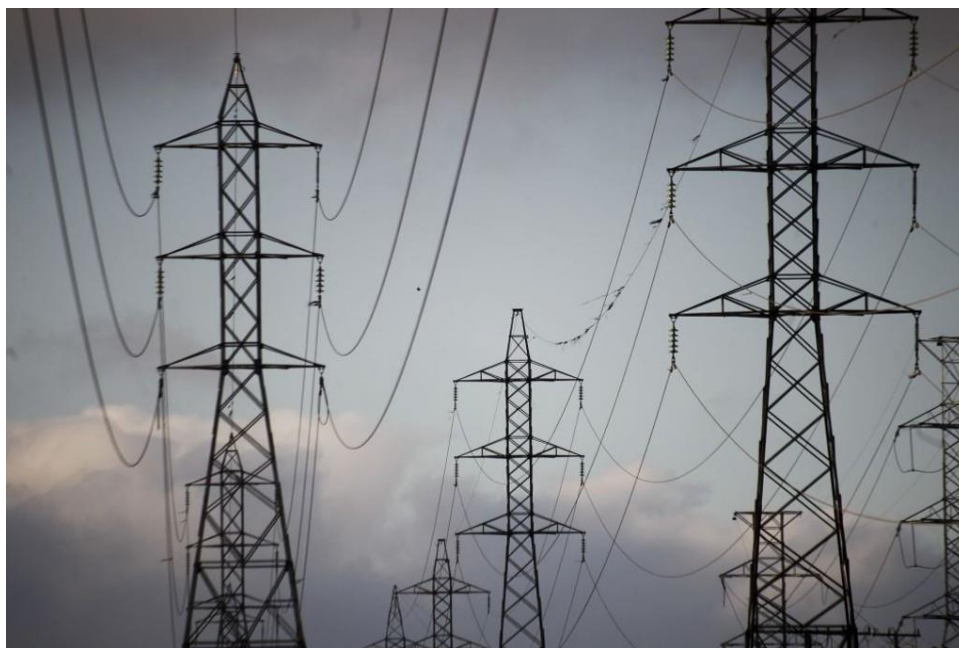
Figura 2.13 – Cabos condutores instalados nas linhas de transmissão
