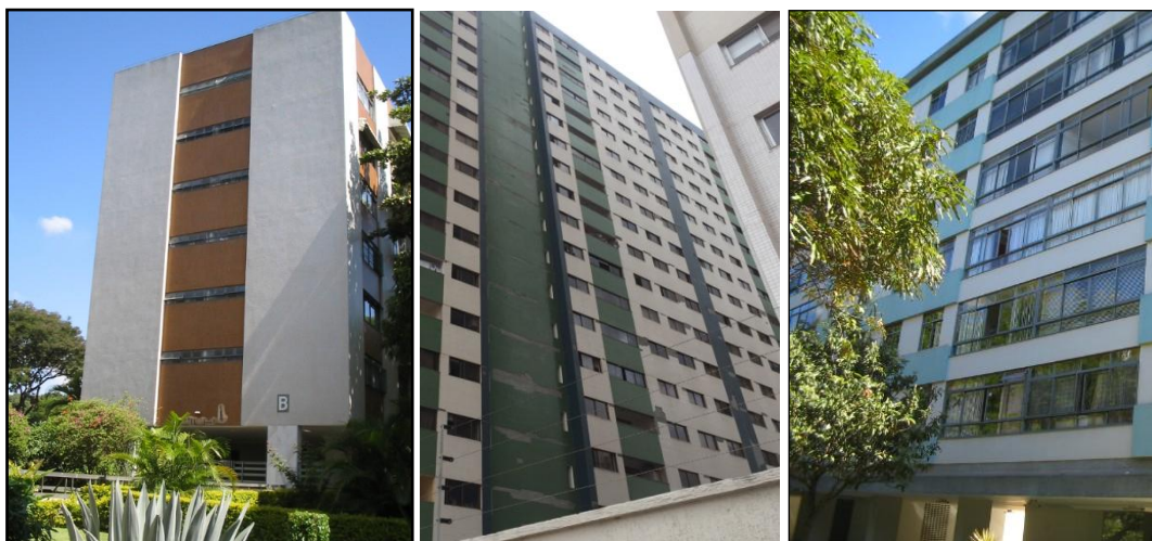
Figura 3.4 – Exemplos de aberturas: a) Percentual de abertura menor que 20%; b) percentual de abertura entre 20 e 50%; c) percentual de abertura maior que 50%.
