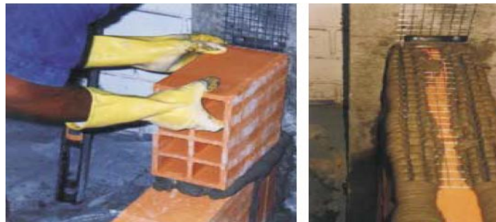
Figura 2.7 - Execução de alvenaria com reforço de tela metálica na interface alvenaria-pilar. (SILVA, 2003)
