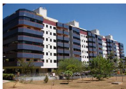
b) Fachada Norte
